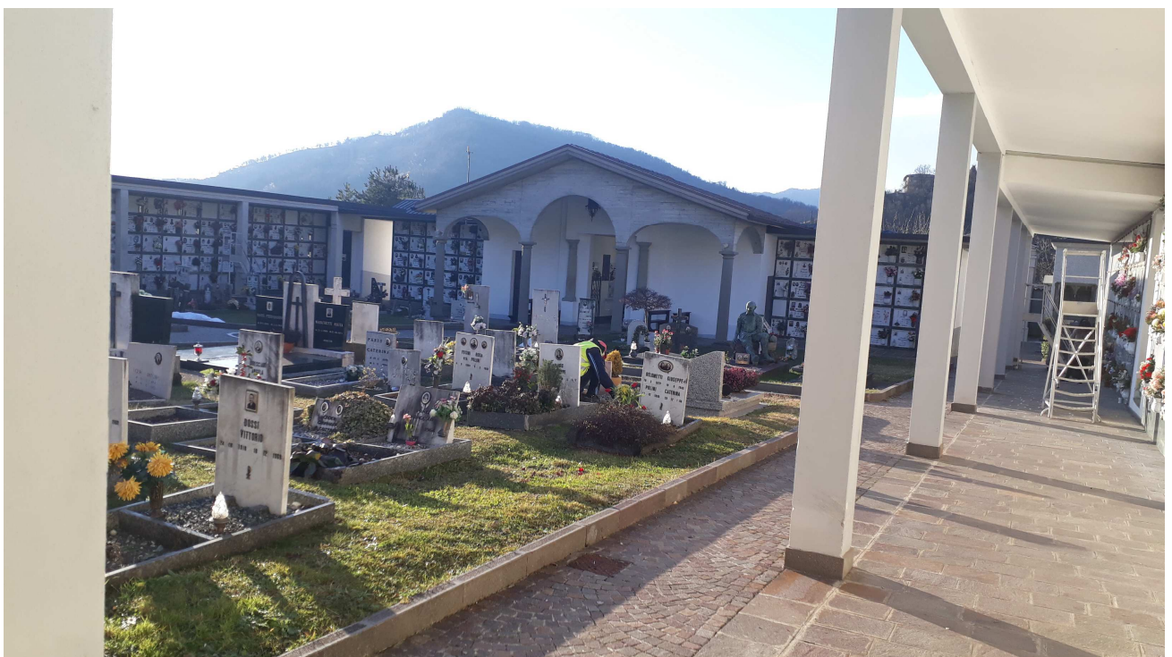
Foto 05: Emergenze tipologiche (Chiesetta-Camera mortuaria-Deposito)
